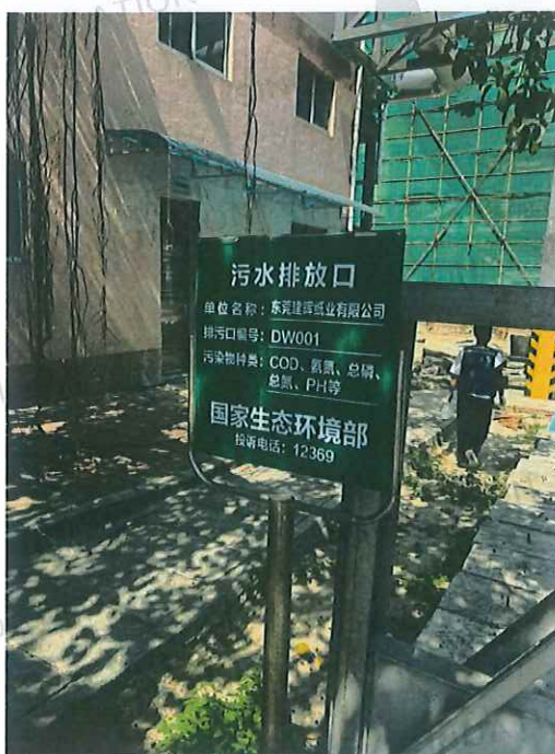
造纸废水排放口 (DW001) 排污铭牌
