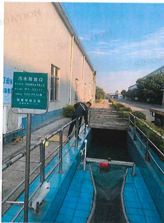
造纸废水排放口
