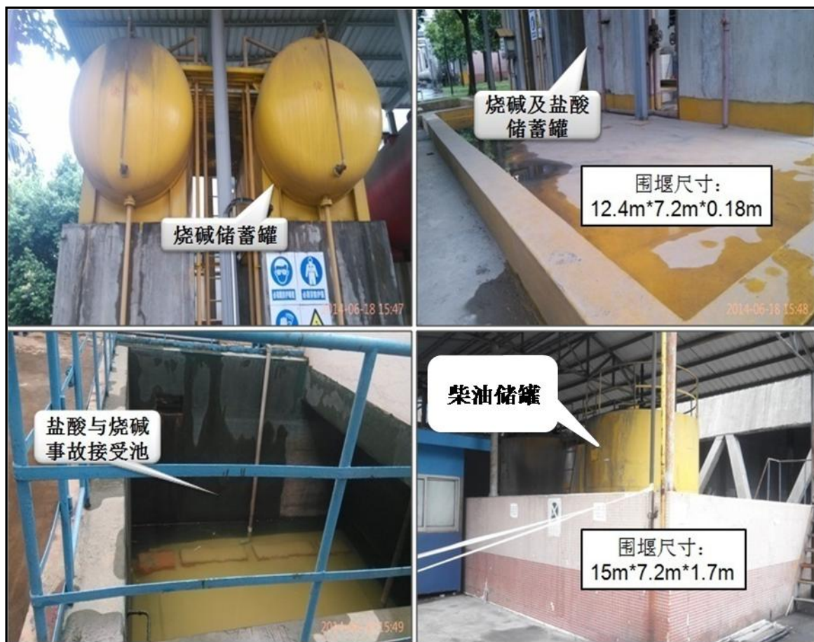
图 3-19 储罐及围堰情况①
