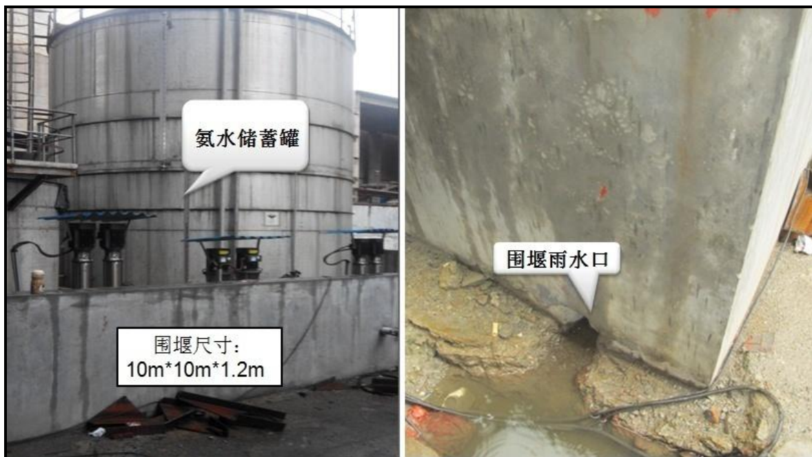
图 3-20 储罐及围堰情况②
