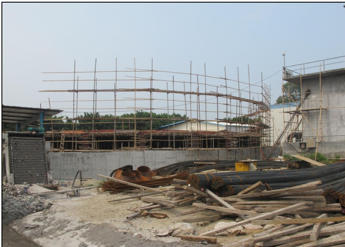
图 3-23 事故应急池建设现状
