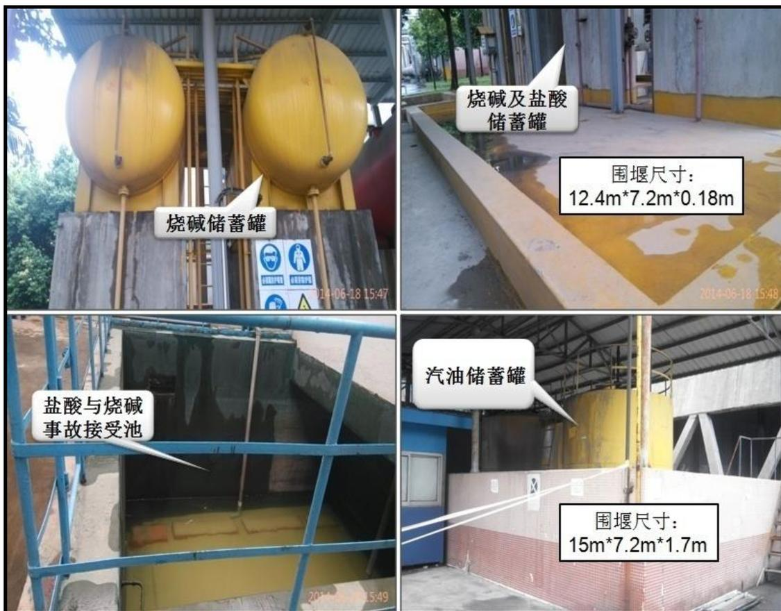
图 3-22 储罐及围堰情况①
