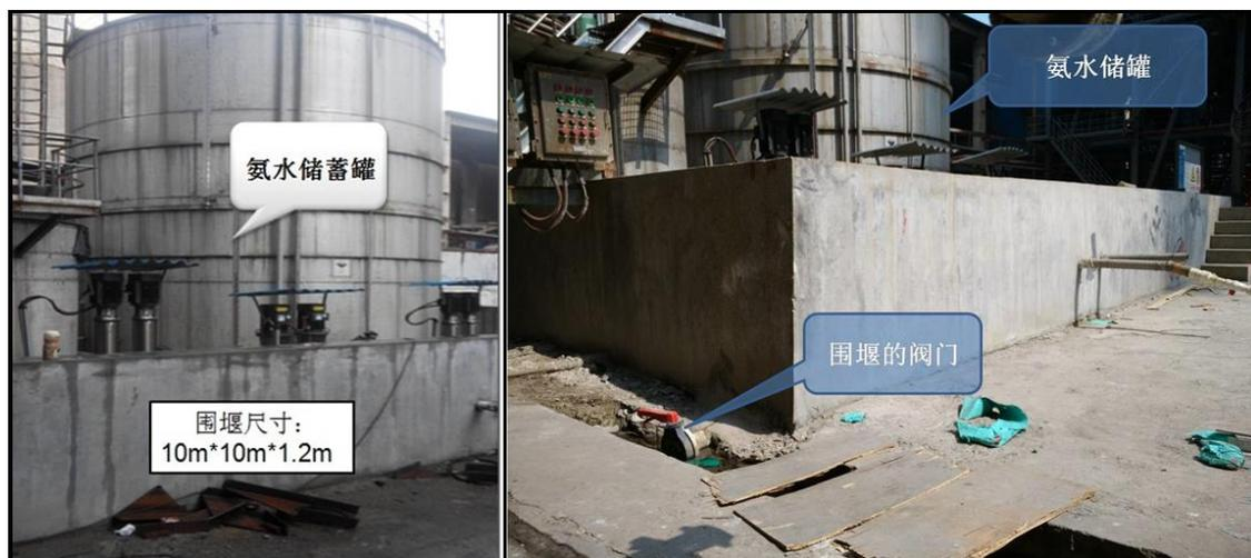
图 3-23 储罐及围堰情况②
